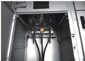
高圧電線異常音発生源特定
